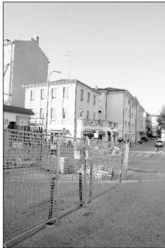
STAZIONE L'area dove verrà costruito il nuovo Bicipark
