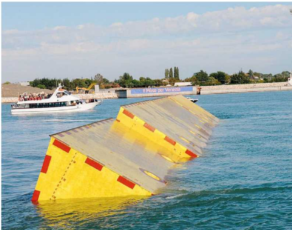
Le prove di funzionamento del Mose a Punta Sabbioni
