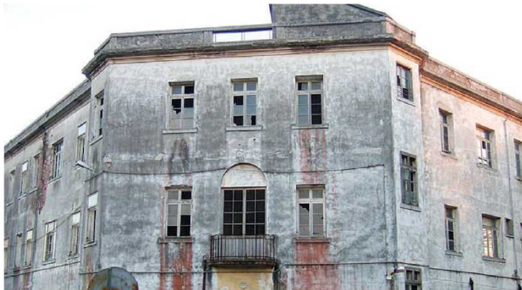
Evidente il degrado dell'edificio che ospitava l'Ospedale al Mare
