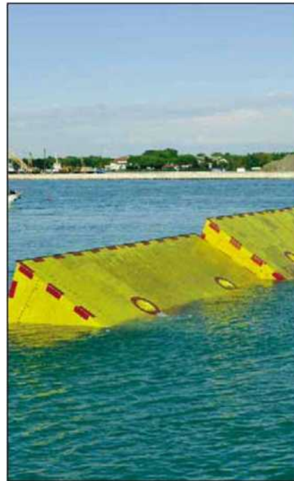
MOSE Le prove di movimentazione delle paratoie
