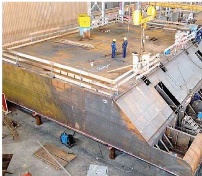
La paratoia del Mose in costruzione a Monfalcone
