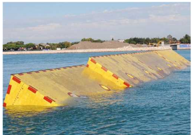
Le paratoie del Mose durante le prove di sabato scorso a Malamocco
