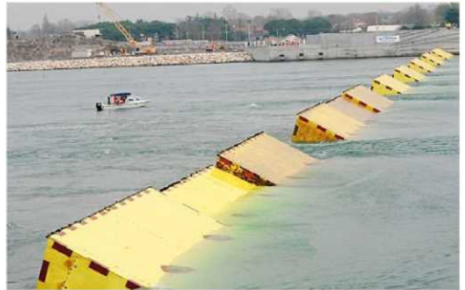
La paratoie mobili del Mose in azione alla bocca di porto
