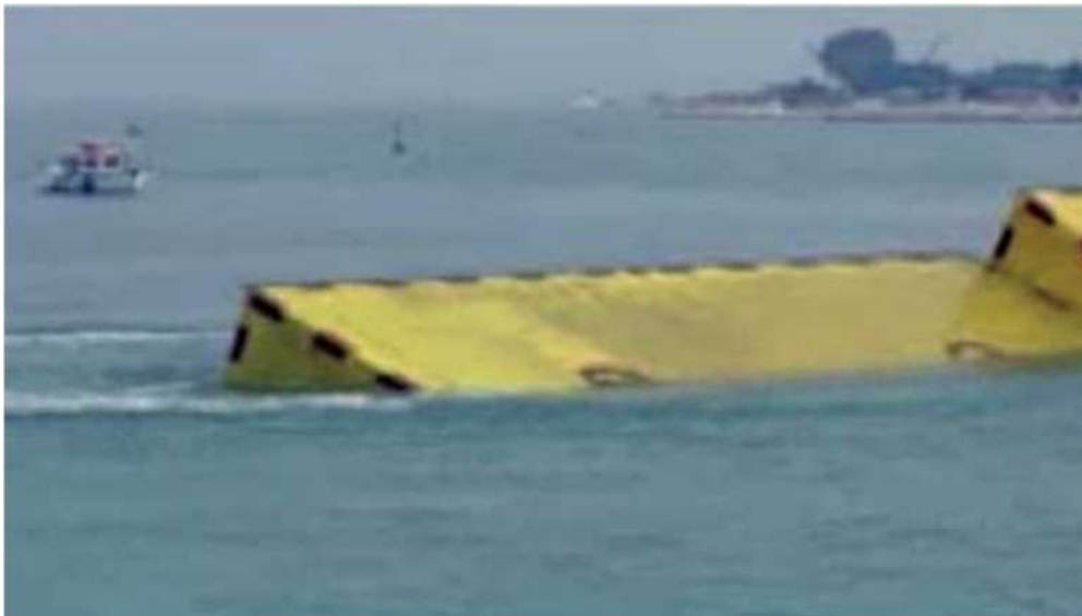
La prima prova Un numero limitato di paratoie è già stato sollevato nei collaudi, oggi il via ufficiale
