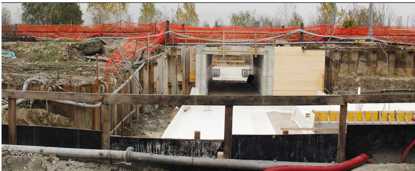
Il sottopasso ciclopedonale e d'accesso alla banchina, realizzato sotto la linea ferroviaria, visibile nel tratto di cantiere allestito alla fine di via Galuppi
