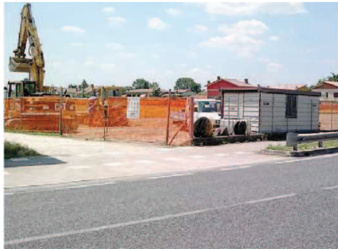
Il cantiere del parcheggio scambiatore di Trivignano
