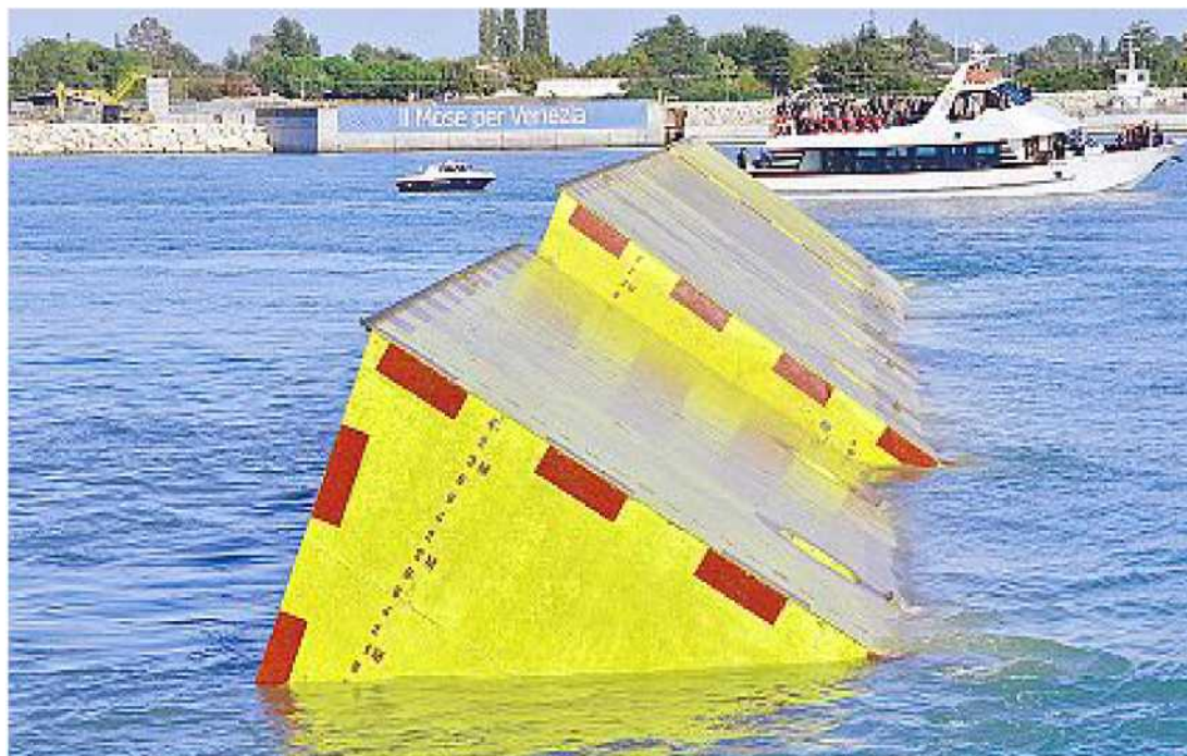
Le paratie mobili del sistema Mose poste alla bocca di porto del Lido di Venezia
