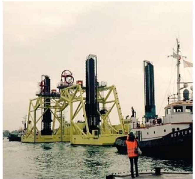
Il "Jack Up" realizzato all'Arsenale per posizionare le paratoie
