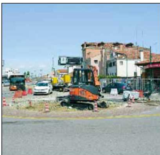
DEMOLIZIONE della rotonda di piazzale Roma per far passare i binari del tram
