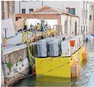
La chiatto con gli impianti
