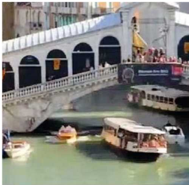
Traffico acqueo in Canal Grande a Rialto
