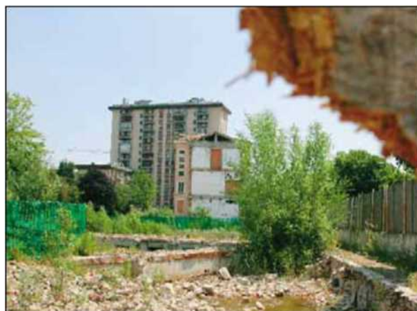
«BUCO» IN CENTRO Il cantiere dell'ex ospedale Umberto I
